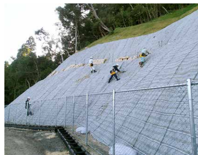
法面緑化工事
