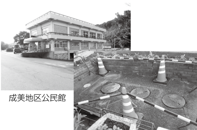
故障した浄化槽
