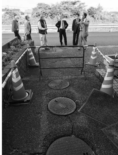
11月6日(金) 現地調査 成美地区公民館 浄化槽
