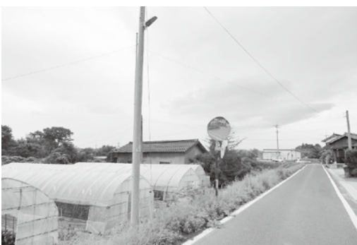
通学路に新たに設置された防犯灯
