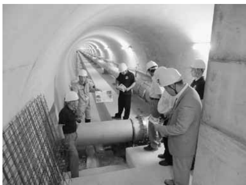
視察の様子（発電施設内部）
