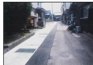
逢東地区水路改修
