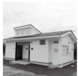
新たに設置したトイレ
