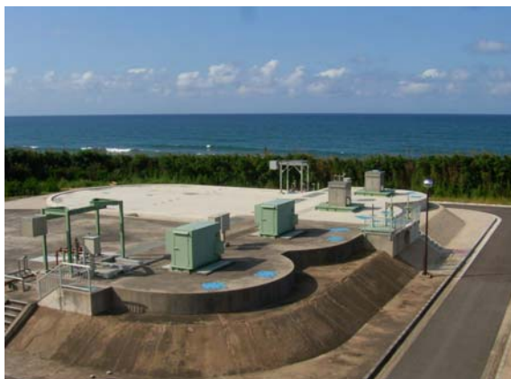
オキシデーションディッチ(OD槽:今回 写真奥側施工)
