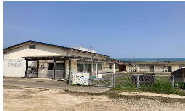
旧逢東保育園 昭和46年築 木造 延床：421.35m 2 解体後：民間提案
