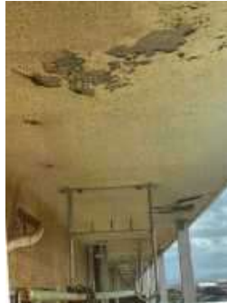
老朽化したベランダ天井の修繕
