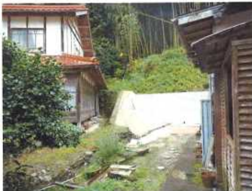
対策施設端部 起点側
