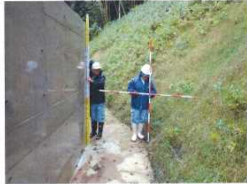
対策施設端部 擁壁背面状況
