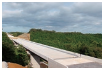
東伯中山道路赤碕第3高架橋床版工事
