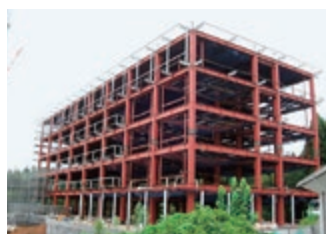
鳥取看護大学の鉄骨建方
