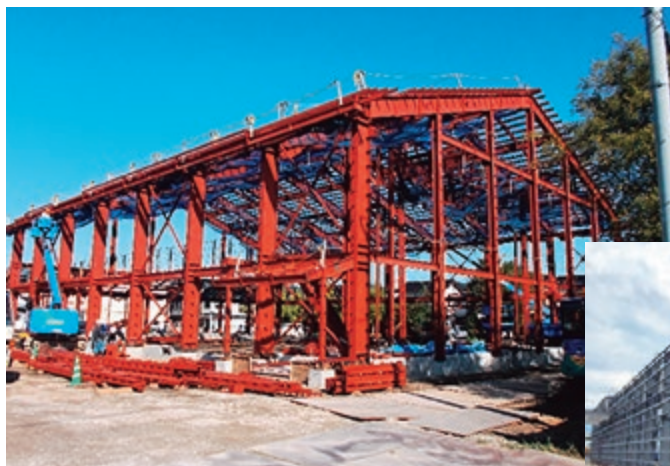
上灘小学校屋内運動場 鉄骨工事
