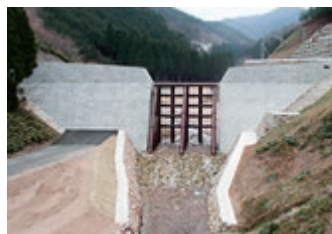
浅井2号砂防堰堤工事
