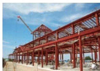
琴浦物産館の鉄骨建方
