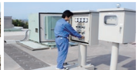
下水道維持管理
