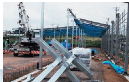
岸田牧場建て方状況
