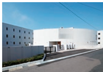
鳥取看護大学学生寮新築工事
