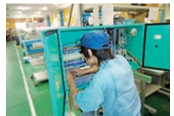
制御部の配線中 真剣です!
