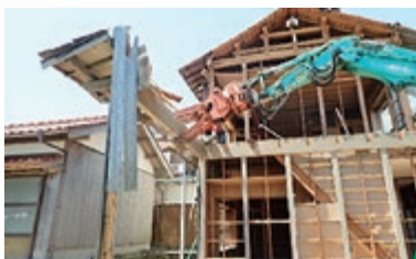
機械や人力で解体します!!
