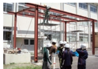
米子高専 鉄骨建方実習風景
