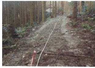
作業道開設後
