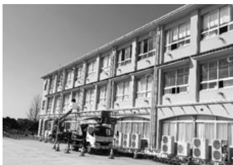
赤碓小学校工事の様子
