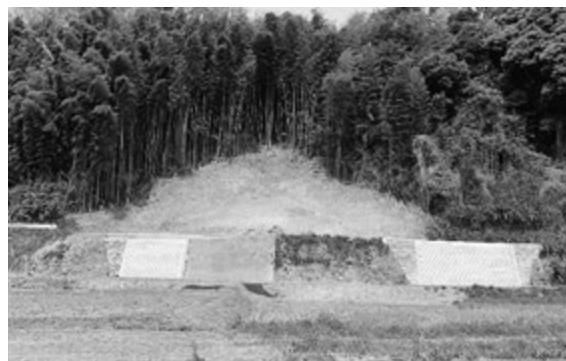
4月末時点 工事経過
