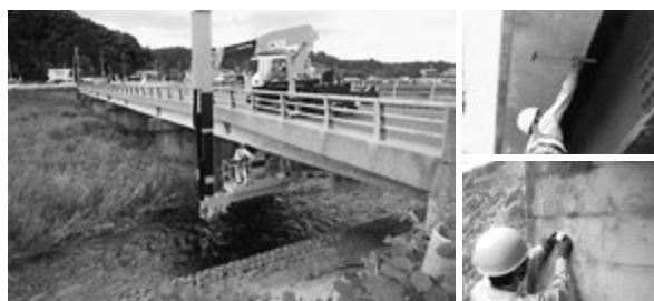
橋梁点検車での点検風景
