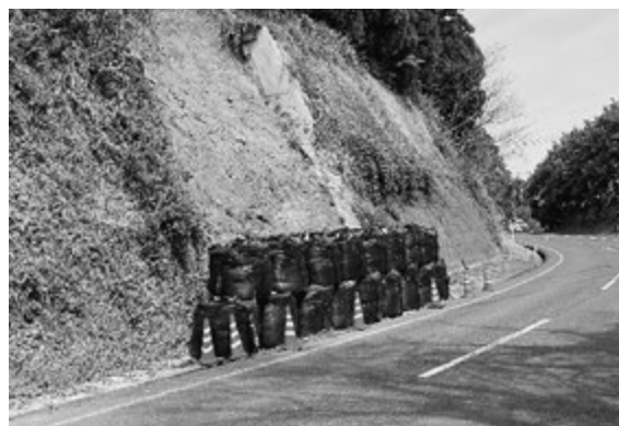
応急工事後(令和元年度中に復旧予定)
