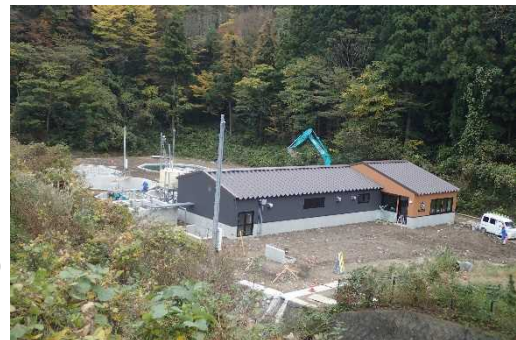
(建設中の船上山採卵センター)
