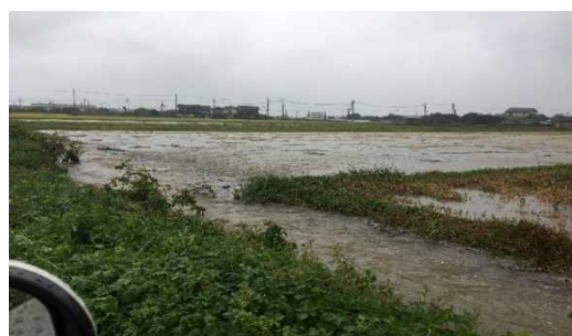
▲田越地内の用水路の流出状況
