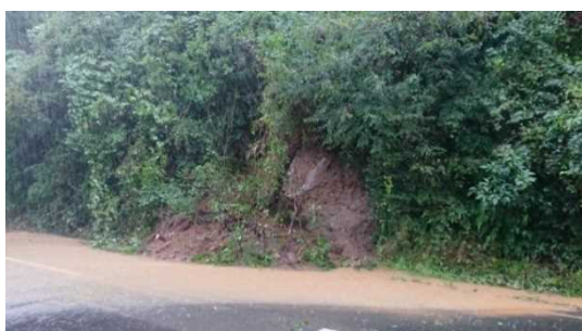
▲大杉地内の土砂崩れ箇所
