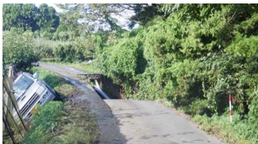
▲人的被害のあった倉坂地内の崩落箇所
