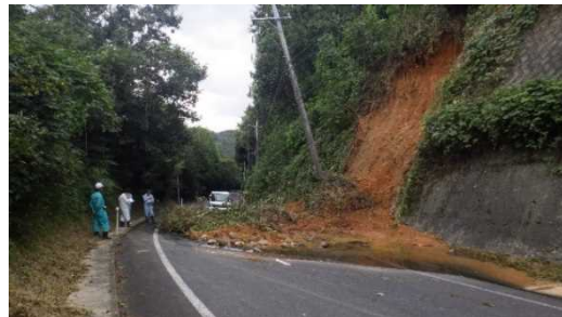
▲岩本地内の土砂崩れ箇所
