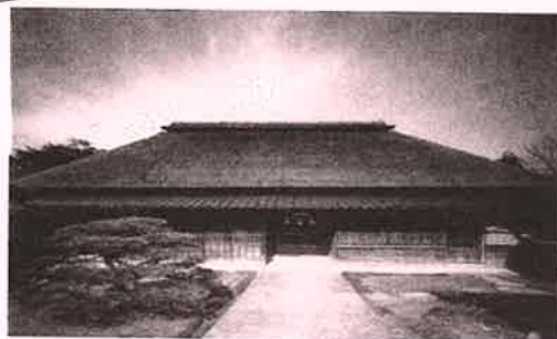
貞享5年(1688)に建築された主屋
