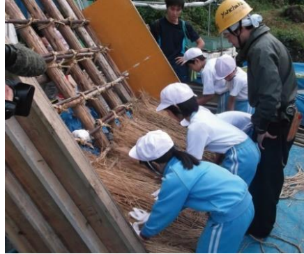
重要文化財建物の屋根葺き替え作業に参加する地元の小学生 〔福井県池田町堀口家住宅〕 (「福井県の住教育活動～中間とりまとめ～」福井県土木部建築住宅課提供)
