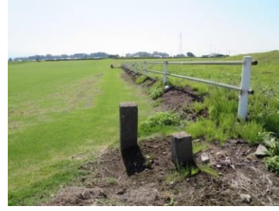
境界標(昭和15年度設置) 境界の内側に囲柵を設置している
