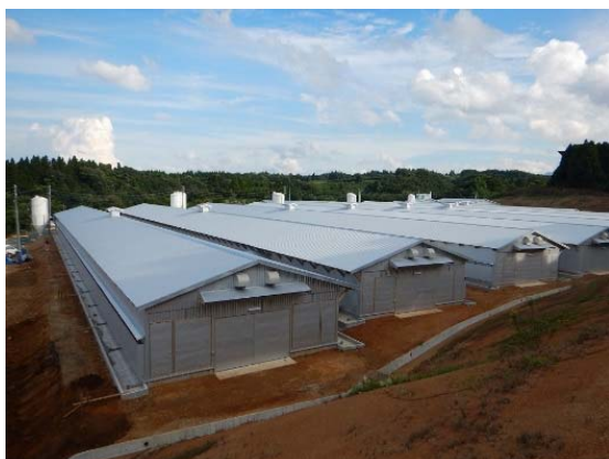
第 1 期工事が完成した帽子取鶏舎
