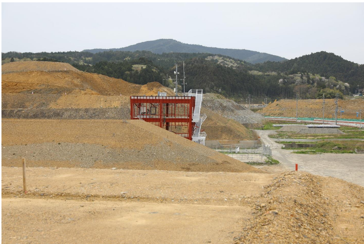
10mの盛土から見える津波被害を受けた防災対策庁舎
