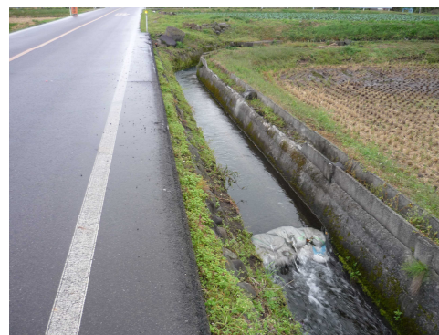
【車両撤去、及び土嚢設置の様子】
