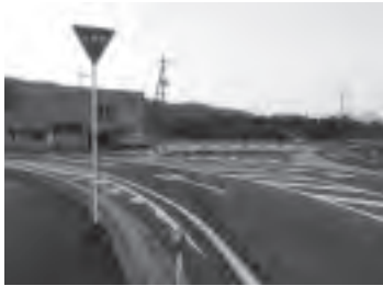
以西バイパス道路変則三叉路
