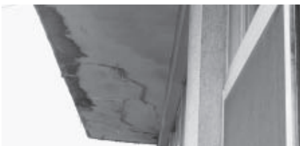
老朽化した浦安公民館外壁（天井）
