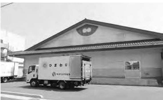
炊き出しの拠点となる給食センター
