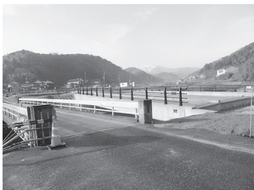
架け替えが予定されている東大杉橋
