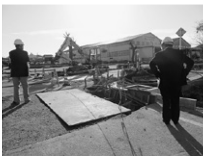
徳万の水害常習解消のための雨水バイパス工事現場
