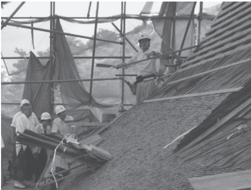
屋根葺替工事が行われている神崎神社を視察
