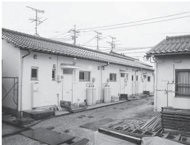
改修中の町営住宅いなり団地
