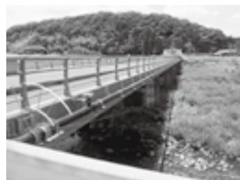
配水管（成美橋添架管）
