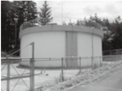
大父木地配水池
