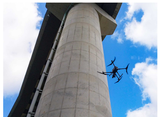
「無人航空機(マルチコプター)を利用した橋梁点検画像取得装置 M300RTK-i」 【BR010028-V0223】
