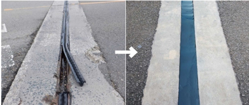
「ゴム劣化取替工法」【NETIS QS-180049-A】
