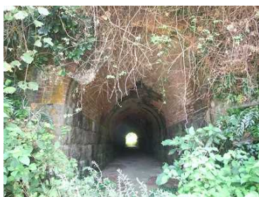
ふしぎなトンネル
