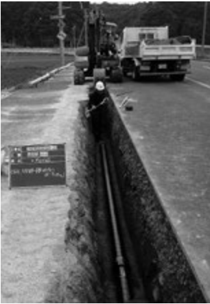
上水道配水管敷設替工事
