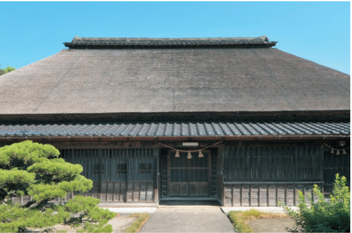
門から母屋全景を見る 撮影：小野吉彦
