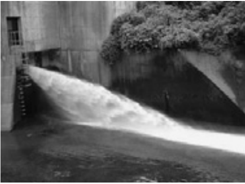
船上山ダムから放水される農業用水
